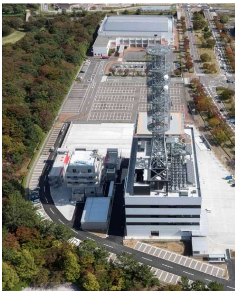
鳥瞰（西方向より）
