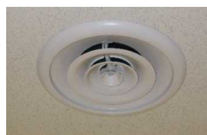
写真6 シーリングディフューザー
